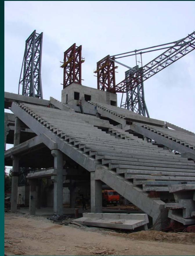
**Montažne konstrukcije:** Stubovi, grede, ploče.
